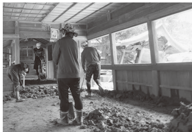
被災地での復旧作業
