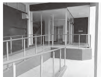
入口スロープ
